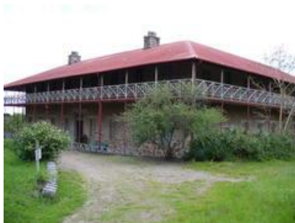
Vista actual del Hotel - Restaurante
