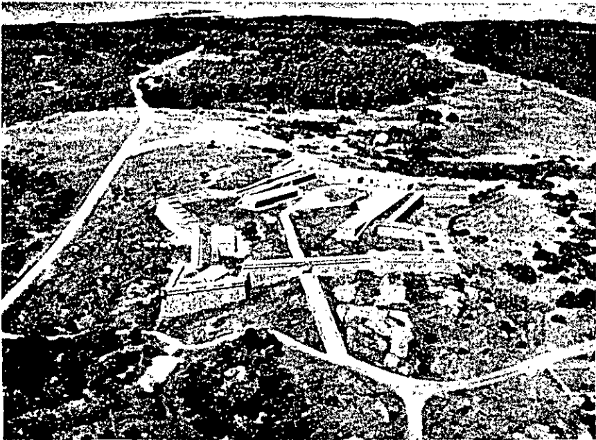
Vista aérea de la fortaleza al terminar la restauración.
