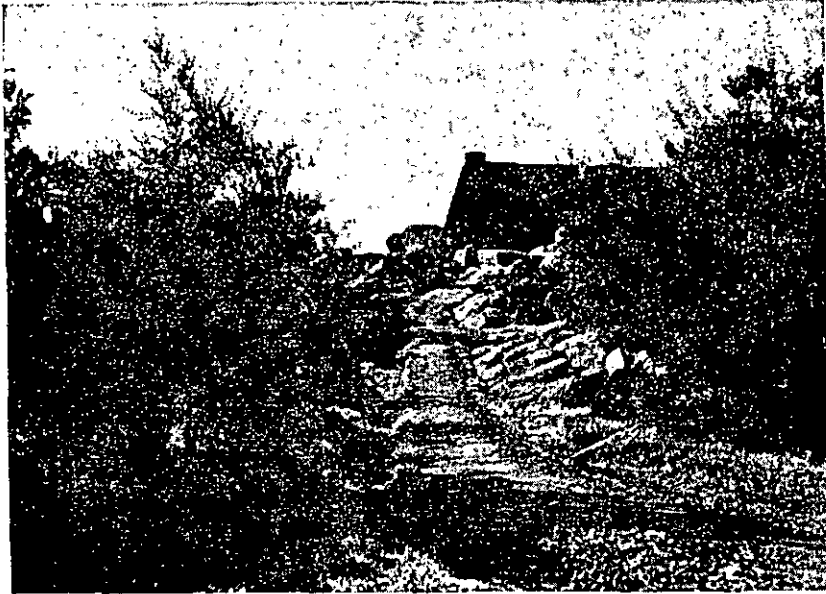
El primer sendero construido al fuerte.
