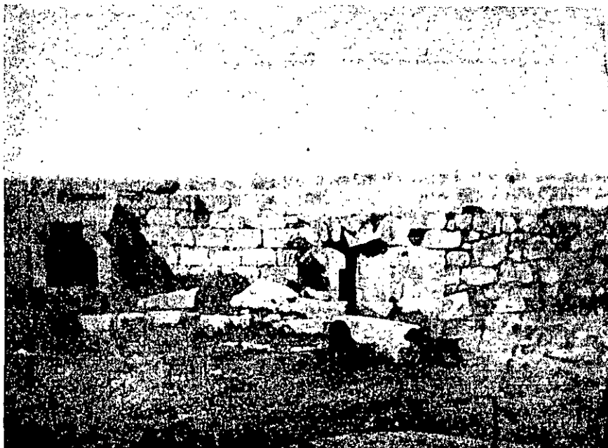
Parte trasera de la Puerta del Socorro antes de la habitación de 1895.
