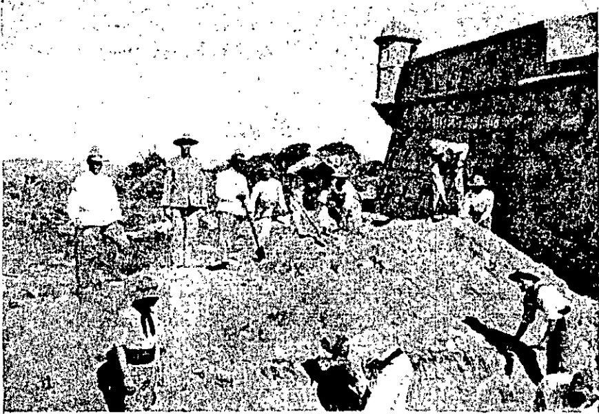
Desenterrando los muros invadidos.
