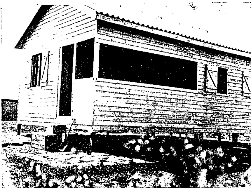
La casilla sobre pilotes, por las cruceras y las tarántulas.
