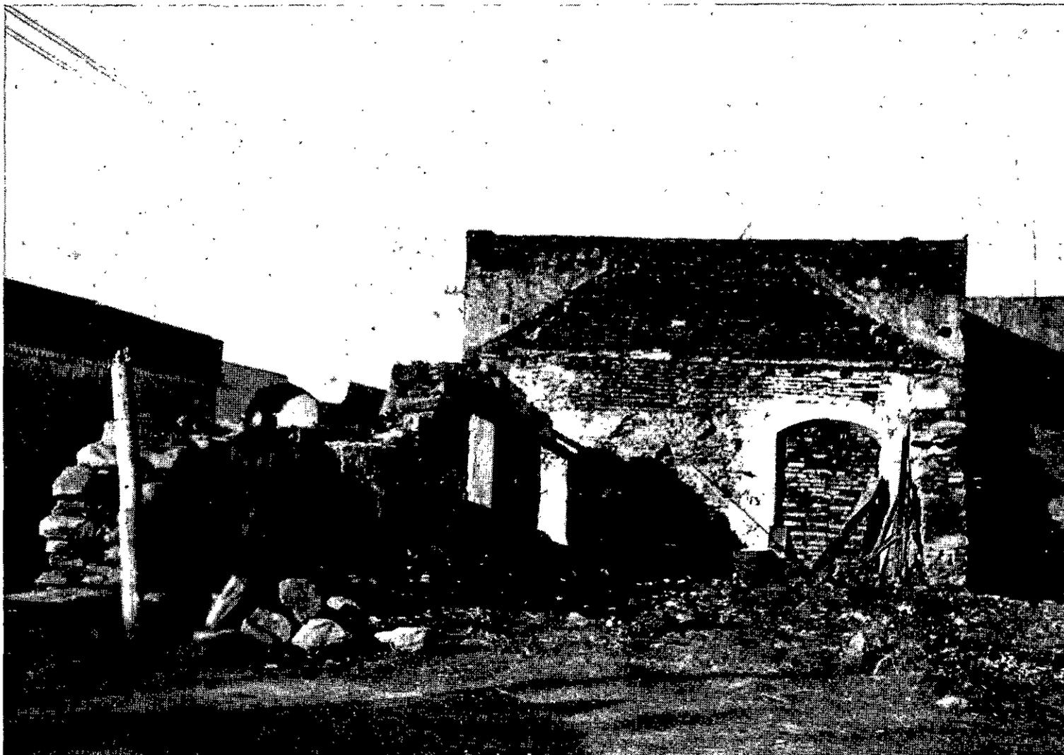
FIG. 25. — Cuartel de Dragones. Puerta de jambas y arco escarzano de piedra que ponía en comunicación el corredor de entrada con el Cuerpo de Guardia.
