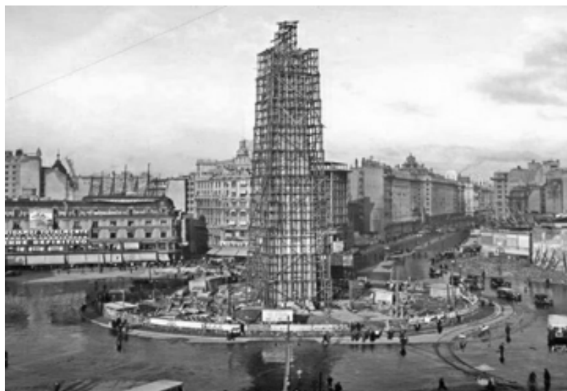
Construcción del Obelisco en 1936.
