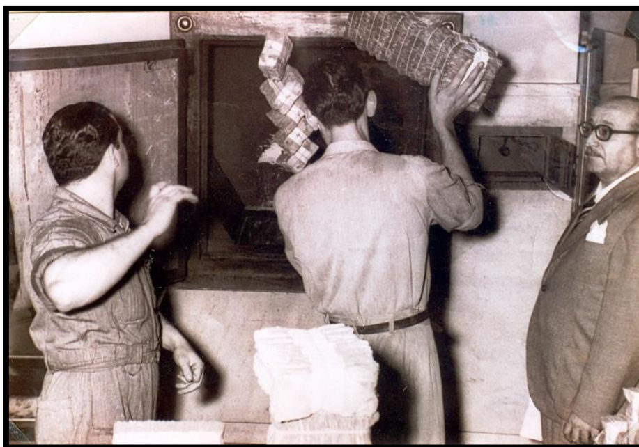
Sector de incineración de numerario de la Tesorería del BCRA. Se observa personal portavalores y administrativo procediendo a la carga del horno para su destrucción.
