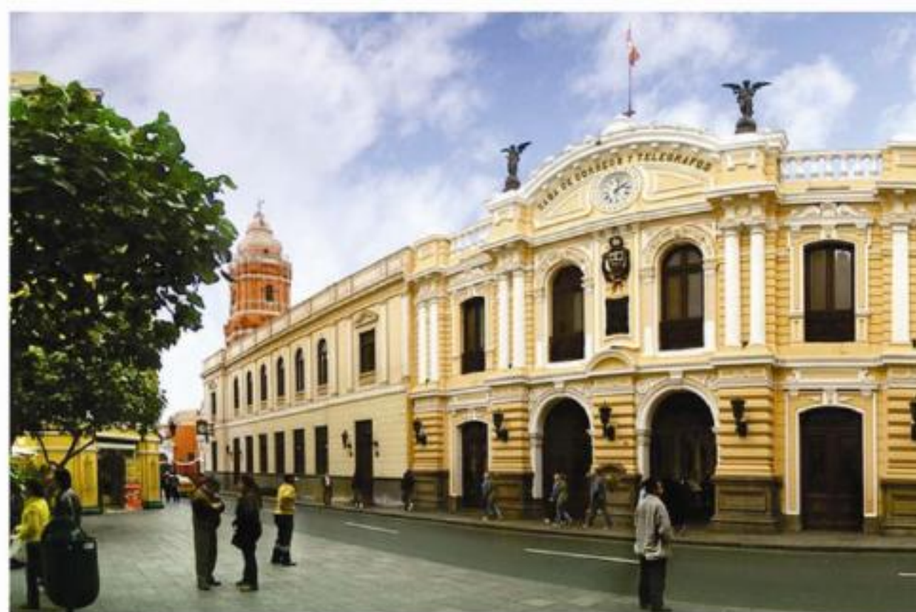
Casa de Correos y Telégrafos de Lima
