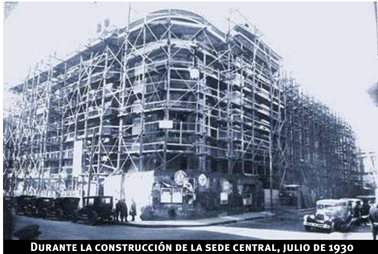
DURANTE LA CONSTRUCCIÓN DE LA SEDE CENTRAL, JULIO DE 1930
