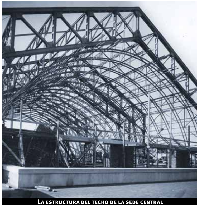
LA ESTRUCTURA DEL TECHO DE LA SEDE CENTRAL
