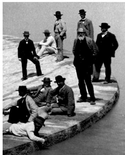
Dique Medrano – Actual Benegas
