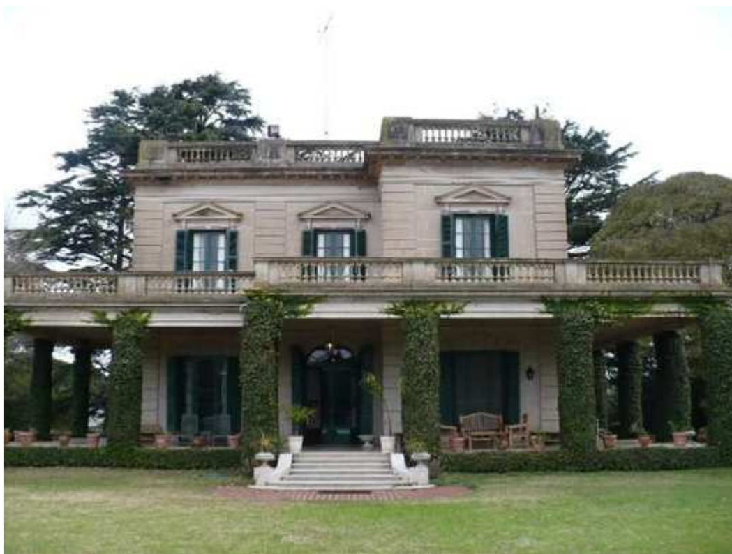
Casco de la estancia, construido en 1900.
