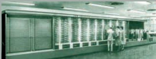
▣ Pennsylvania: primera instalación electrónica de cálculo.
