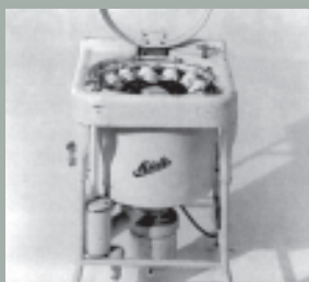
□ Lavaplatos 'Miele' con el motor eléctrico en la base
